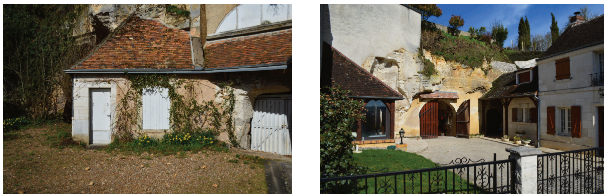
Figure 7 – Habitat troglodytique à Villiers-sur-Loir.
