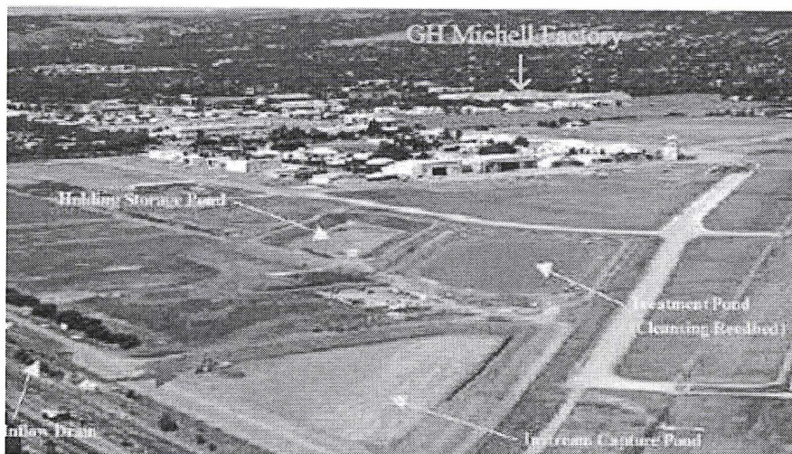
Photo 11 : Vue aérienne du site des trois bassins pour le projet de recharge de nappa à Adélaïde
