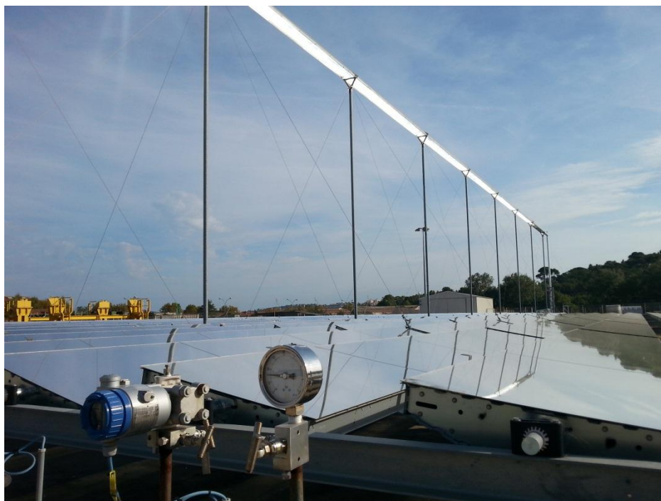
Figure 2 : installation de conversion thermique du rayonnement solaire sur le site de la CNIM à La Seyne sur Mer dans le Var (Credit : Roseline Adde-Wald)
