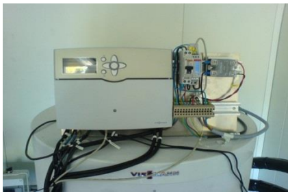
1-Régulateur solaire VITOSOLIC 200SD4
