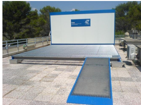
4-Installation module et plateforme solaire
