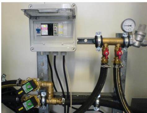
5-Electrovannes et arrivée d'eau
