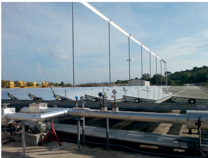
Figure 1. Prototype d'une installation de conversion thermique du rayonnement solaire sur le site de la société CNIM à La-Seyne-sur-Mer dans le Var. Le rayonnement provenant directement du Soleil est concentré par des réflecteurs linéaires de Fresnel sur un tube, en haut sur la photo, dans lequel circule un fluide caloporteur. Le fluide produira de la vapeur qu'une turbine convertira en électricité (crédit photo : Roseline Adde-Wald).
