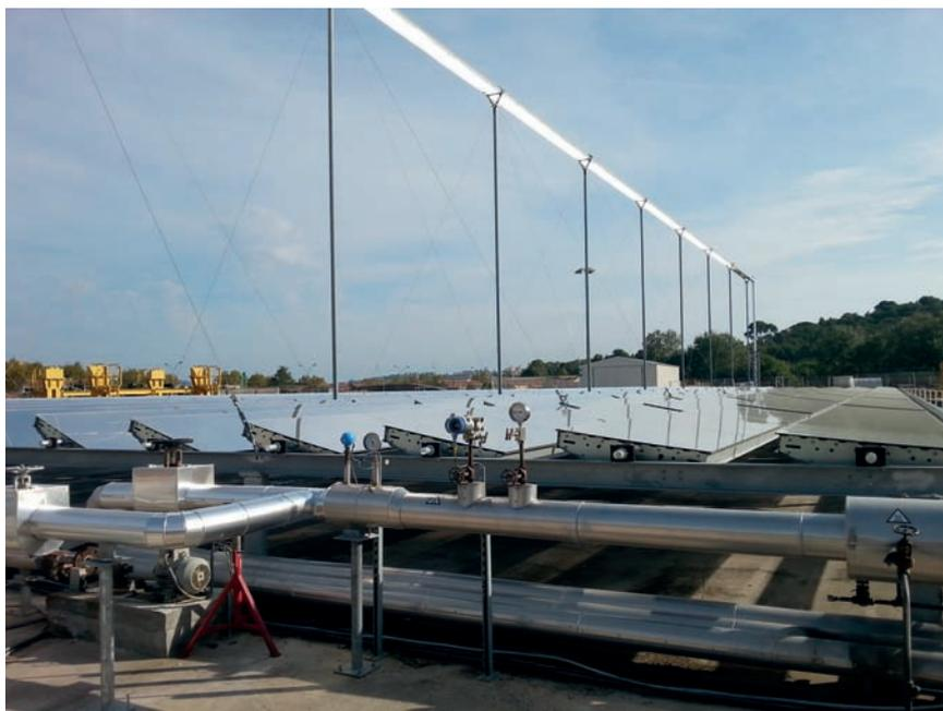
Figure 1. Prototype d'une installation de conversion thermique du rayonnement solaire sur le site de la société CNIM à La-Seyne-sur-Mer dans le Var. Le rayonnement provenant directement du Soleil est concentré par des réflecteurs linéaires de Fresnel sur un tube, en haut sur la photo, dans lequel circule un fluide caloporteur. Le fluide produira de la vapeur qu'une turbine convertira en électricité (crédit photo : Roseline Adde-Wald).
