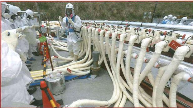
Mise en place du "mur de glace" pour ralentir l'accumulation d'eau contaminée dans le sous-sol de la centrale de Fukushima Daiichi
