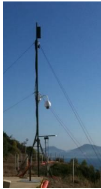
Figure 5 : Système FMCW en place
