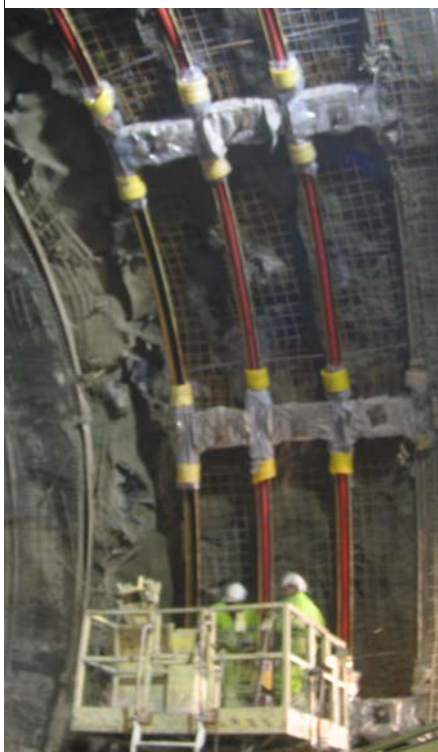
Fig. 14: Pose des blocs compressibles sur les parements
