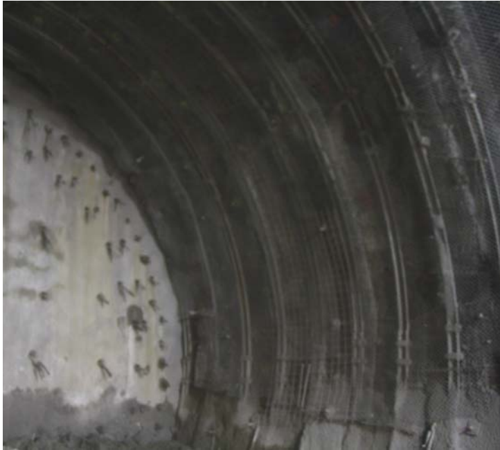
Fig. 9 : Soutènement en première phase et renforcement du front
