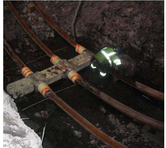
Fig. 10 : Pose des blocs compressibles en contre-voûte
