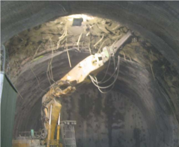
Fig. 11 : Réalésage entre 1 ère et 2 ème phase au BRH
