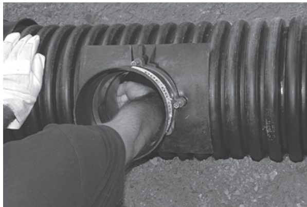
Figure 7 : piquage sur tube annelé
