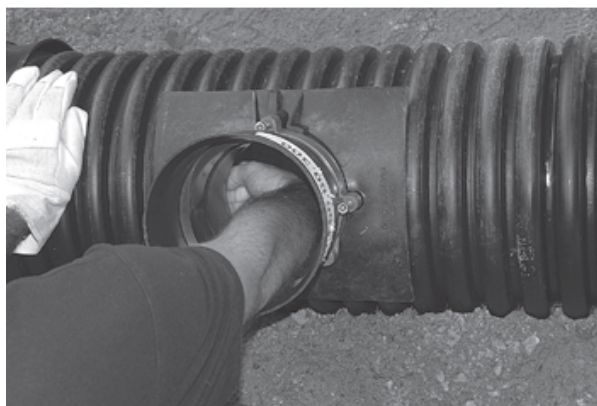
Figure 7 : piquage sur tube annelé
