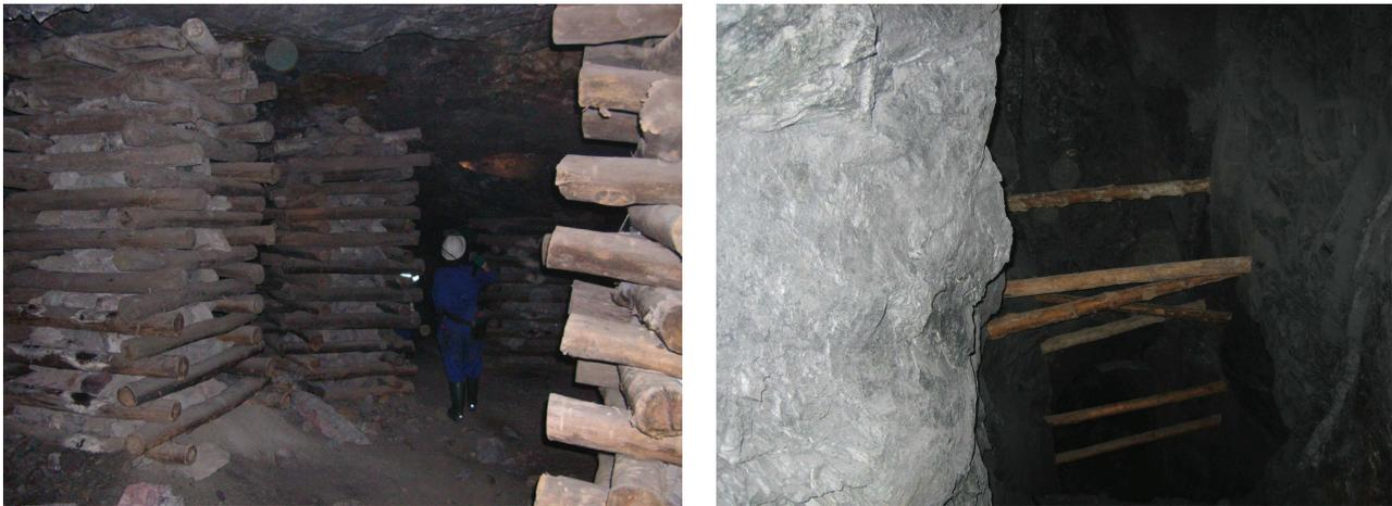
Figure 8: Différentes utilisations du boisage à Bou Azzer : a) piles de bois b) poussards
