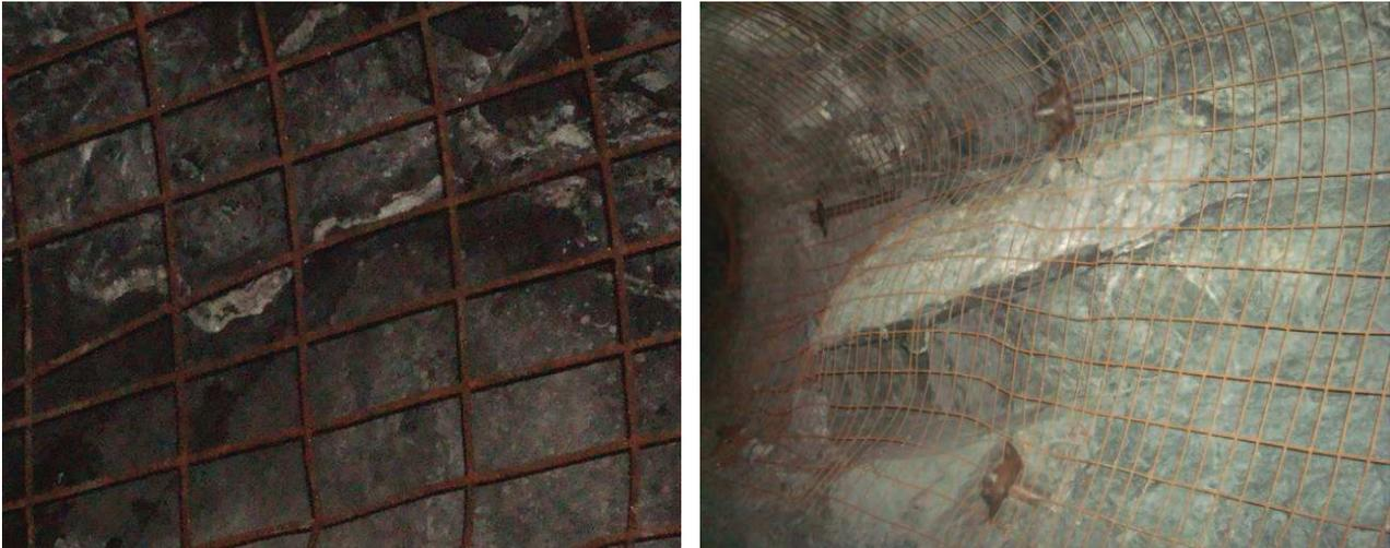
*Figure 18: Photos montrant la retenue des petits blocs par le treillis soudé*
