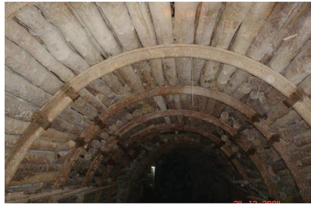
Figure 9: a) Profil "Oméga" d'un cintre b) Photo de cintres avec garnissage boisé dans une galerie permanente
