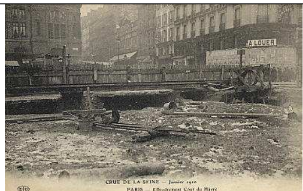
Effondrement de chaussée. Cour du Hâvre (9 ème )
