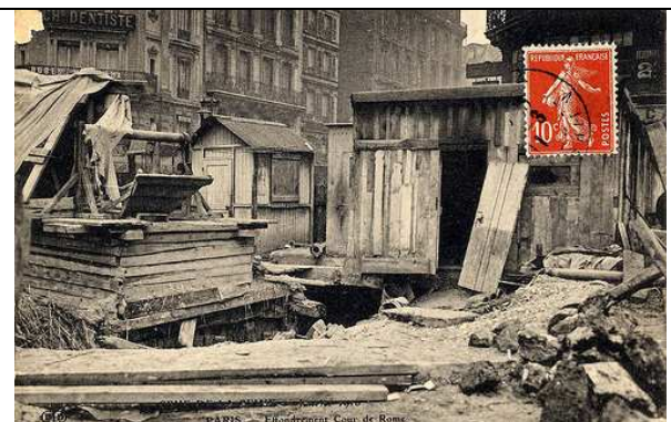
Effondrement. Cours de Rome (8 ème )
