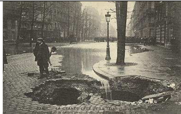
Effondrement de chaussée, après le retrait des eaux. Boulevard Haussmann et rue Pasquier (8 ème -9 ème )
