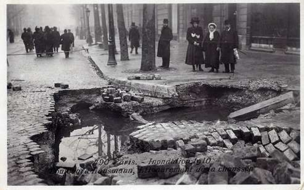
Voûte d'égout effondrée. Boulevard Haussmann (8 ème -9 ème )
