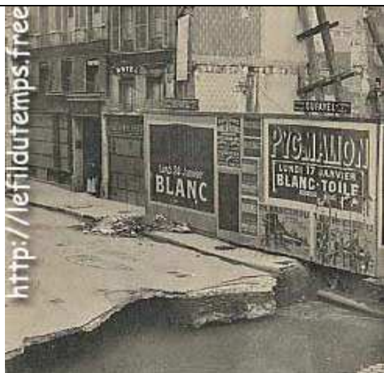
Effondrement de chaussée. Rue Saint-Honoré (1 er )
